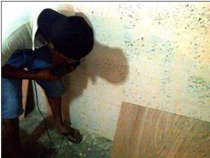
Figura 38: Instalación de pies de amigos para sujetar las láminas de plywood
