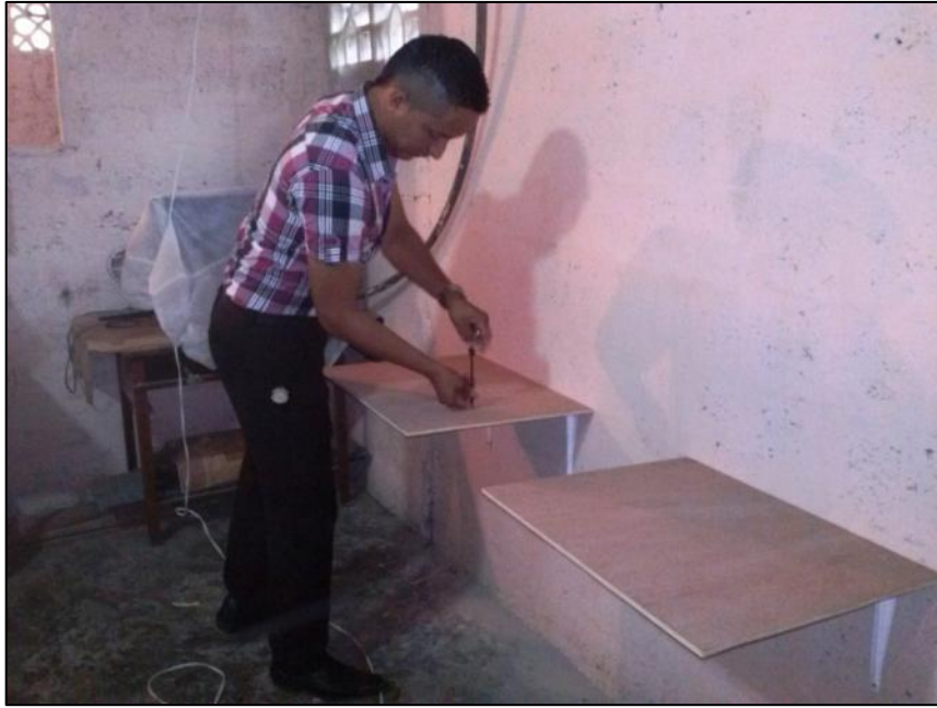
Figura 39: Instalación de láminas de plywood
