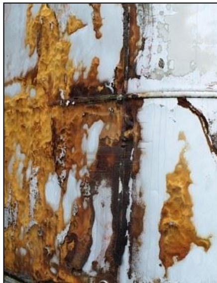
Figura 1. Estructura de hormigón armado cuyas barras de acero se han oxidado
