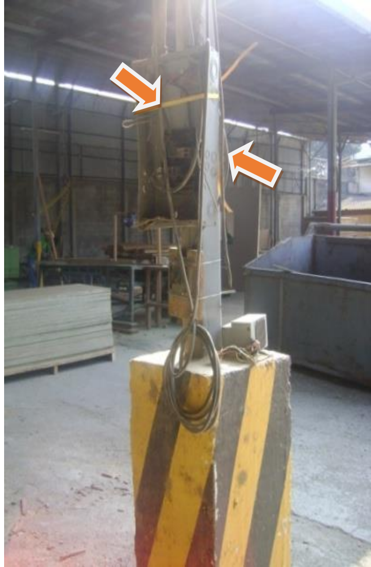
Figura 21. Tablero Eléctrico Abierto Riesgo Eléctrico Fuente: Barrezueta - Morán
