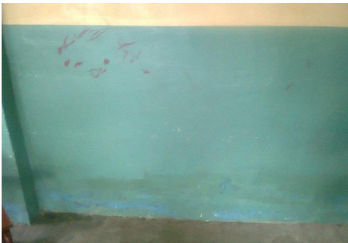
IMÁGENES DE LAS PAREDES AULA DETERIORADAS
