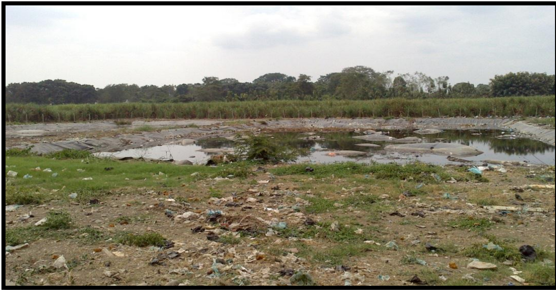
Figura 14. Piscina de lixiviados del relleno sanitario
