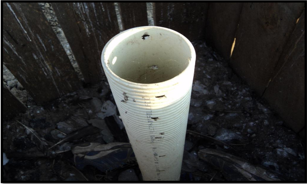
Figura 23. Redes para ventilación de gases
