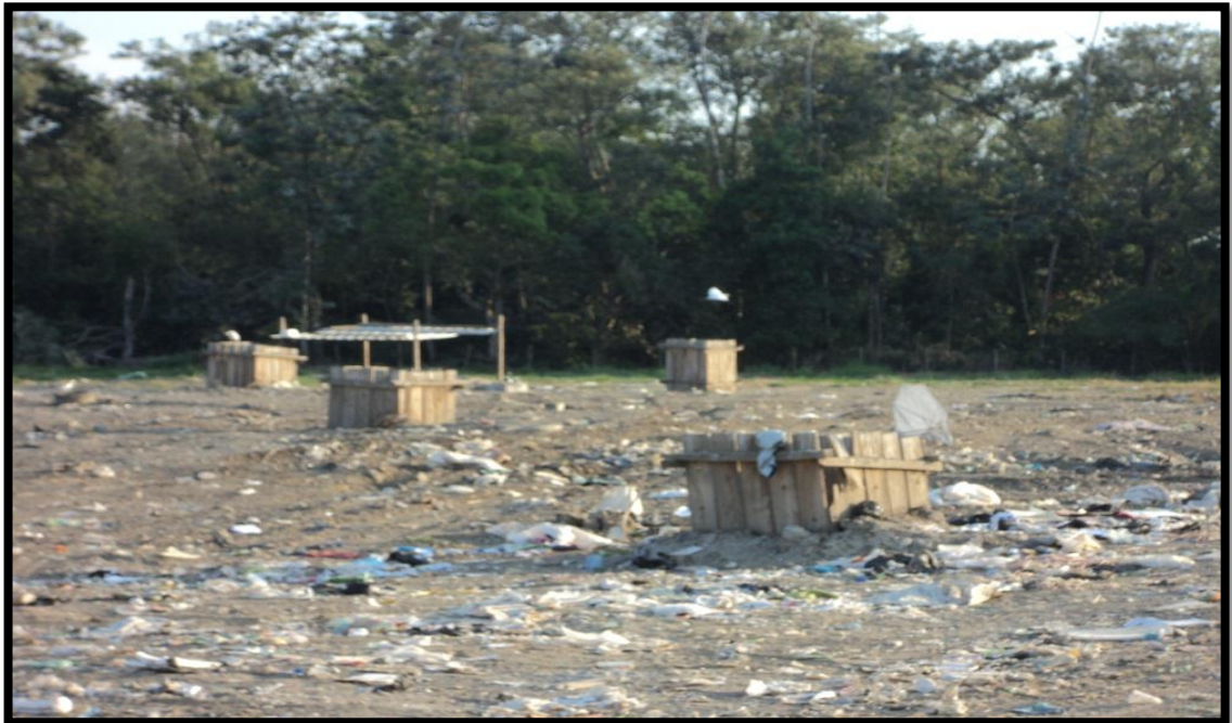
Figura 24. Redes de ventilación al ambiente
