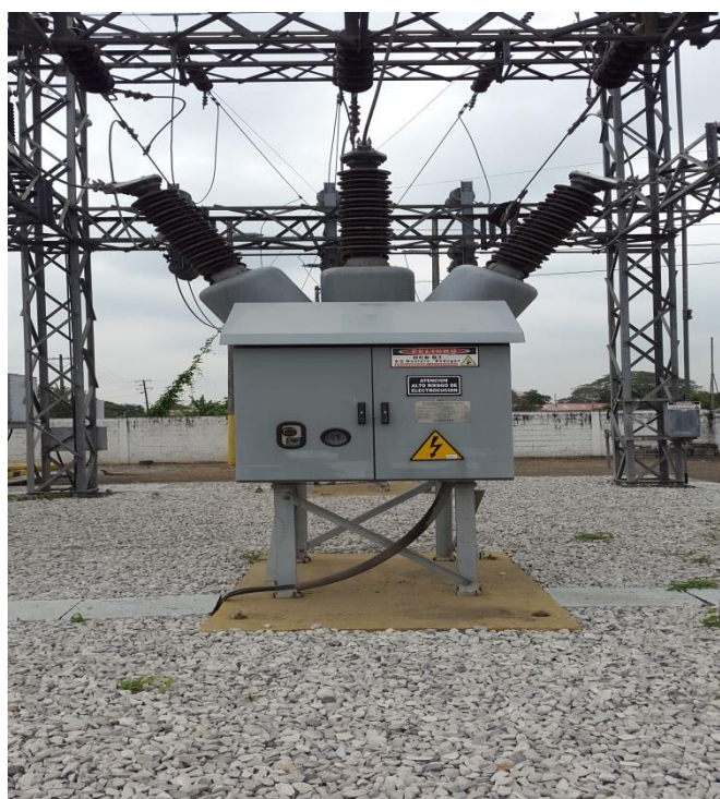
FIGURA 8. Disyuntor de tipo OCB, MONTERO TRIUNFO
