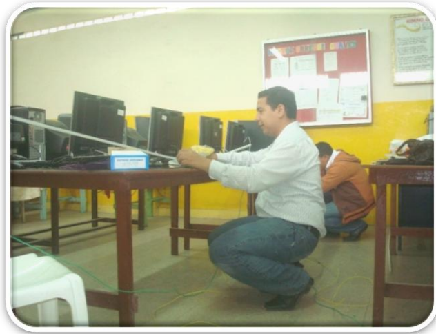
Foto 15. Midiendo los cables que distribuirán energía eléctrica en los puestos de trabajo.
