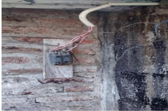
**Figura 4.** Falta de conexión a tierra.
