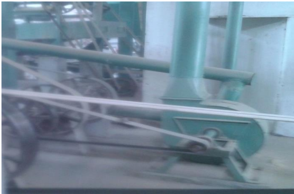
Figura 22. Turbina de extracción
