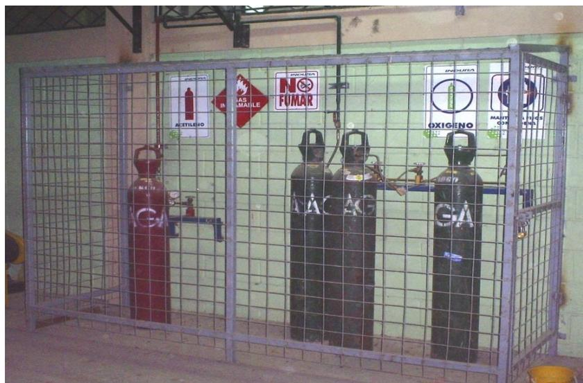
**Figura 6.** Sistema de tuberías de gases de soldadura como gas argón, gas CO<sub>2</sub>, gas MIX, acetileno para oxicorte en el interior de taller de soldadura.
