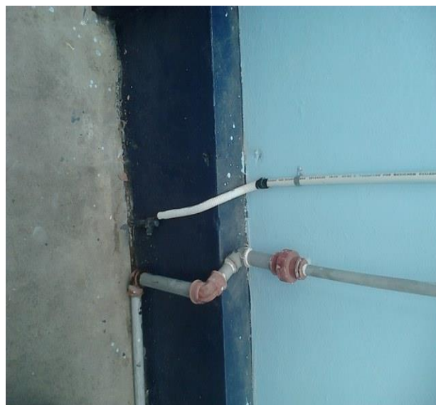
Circuito 2 puesta a tierra AVINNFA
