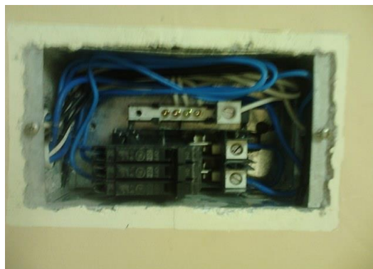
Figura 2. Panel distribución 2 servicios generales AVINNFA
