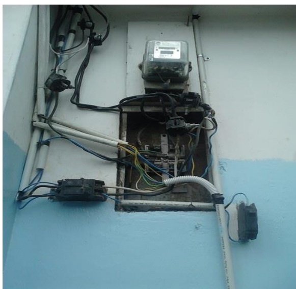
Circuito 1 puesta a tierra AVINNFA
