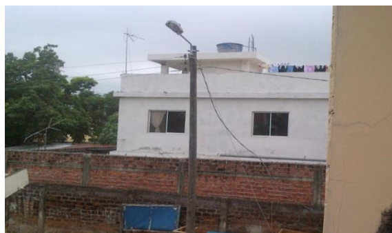
Figura Condiciones eléctricas existentes Colegio Anda Aguirre
