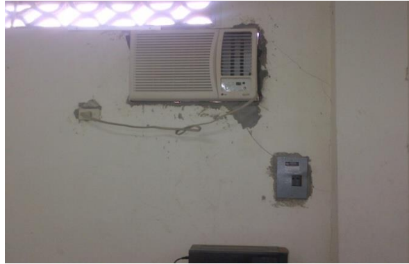
Figura Ubicación del equipo de aire acondicionado
