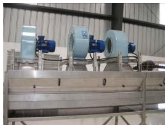
Secado con ventiladores
