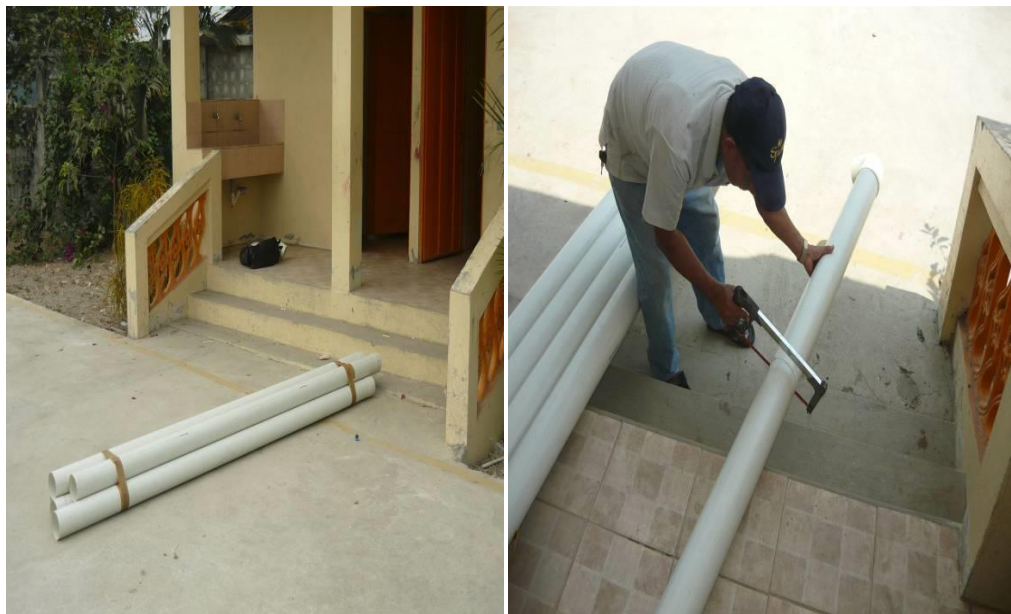
Figura 11. Corte de los tubos PVC
