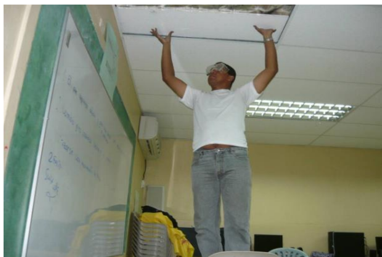
Figura 7. Instalación del sistema o aislamiento térmico
