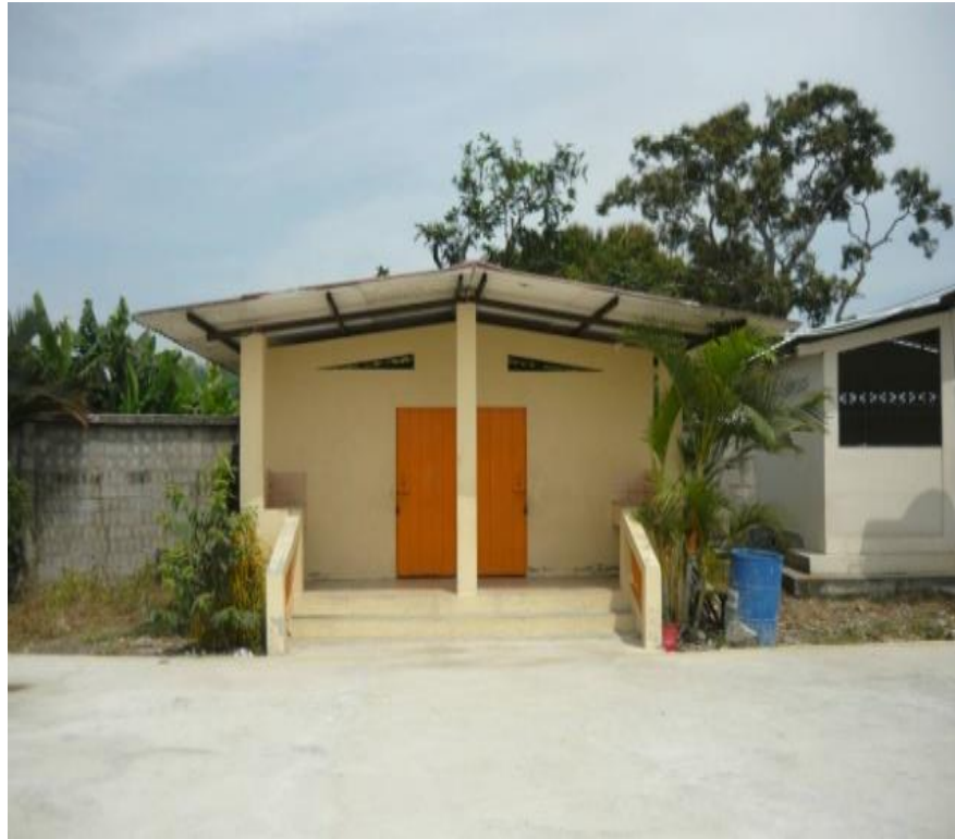
Fachada frontal de los baños de la escuela Lautaro Vera Villegas
