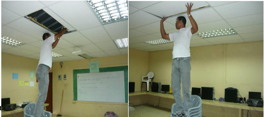
Figura 11. Instalación del Material térmico
