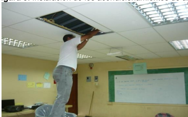
Figura 5. Instalación de los acondicionamientos de aire
