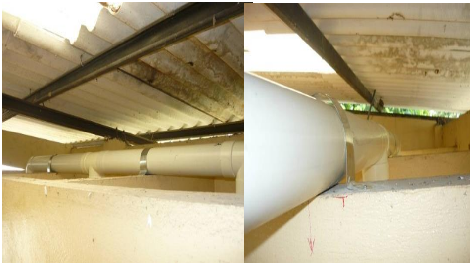
Figura 12. Montaje y sujeción de las redes de ductos
