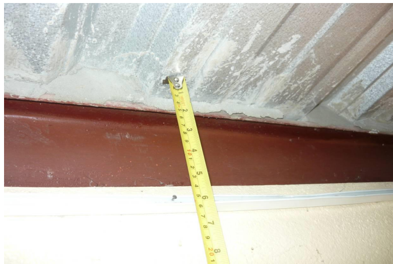
Figura 2. Medición de la cubierta del laboratorio
