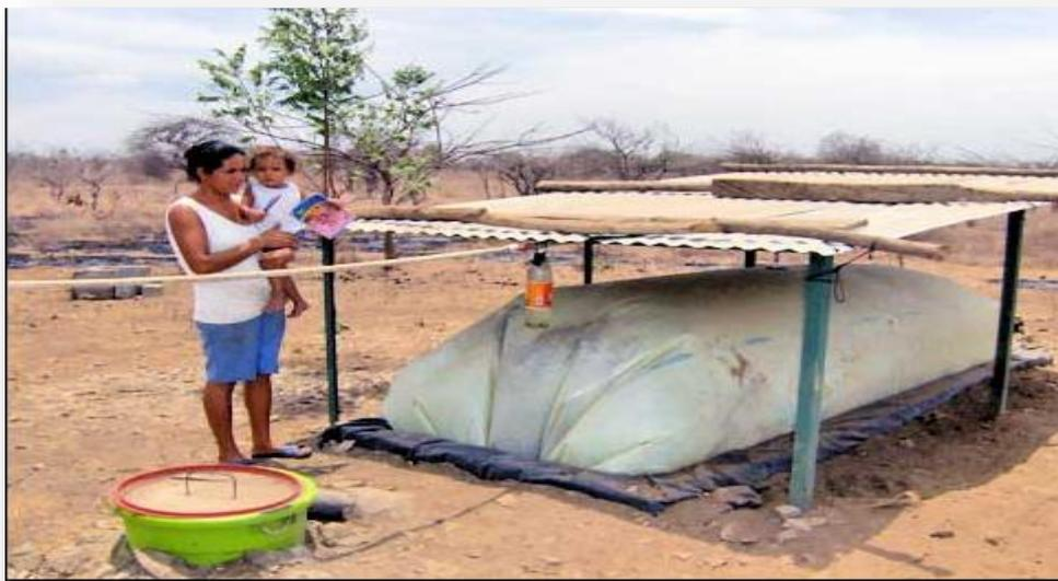
*Imagen 3 Elementos de un biodigestor horizontal*
