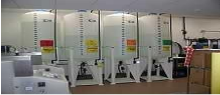
Ilustración 8: Sistema de purificación del agua para el proceso de hemodiálisis
