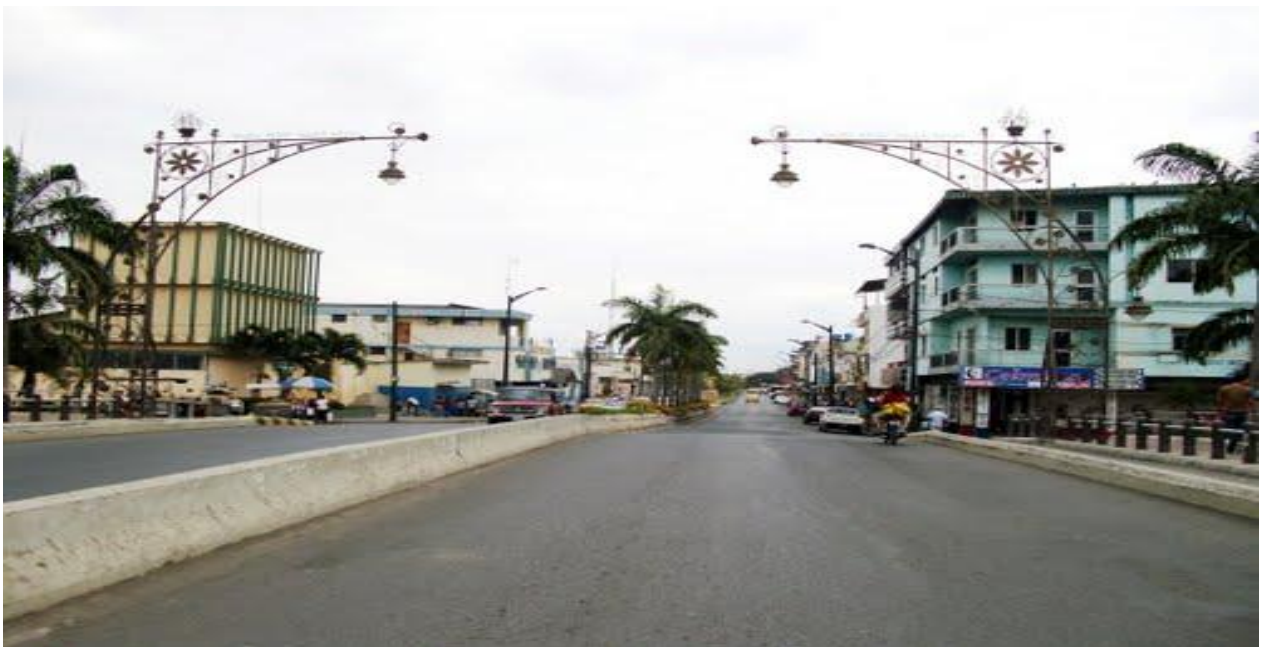
Figura 3. Vista de Milagro Av. 17 de Septiembre Año 2.012. Fuente: Google.
