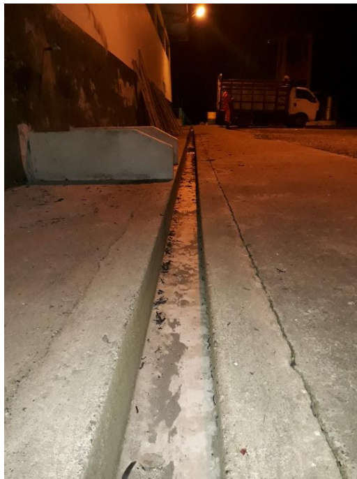
Figura 34: Sistema de drenaje de agua sin protección
