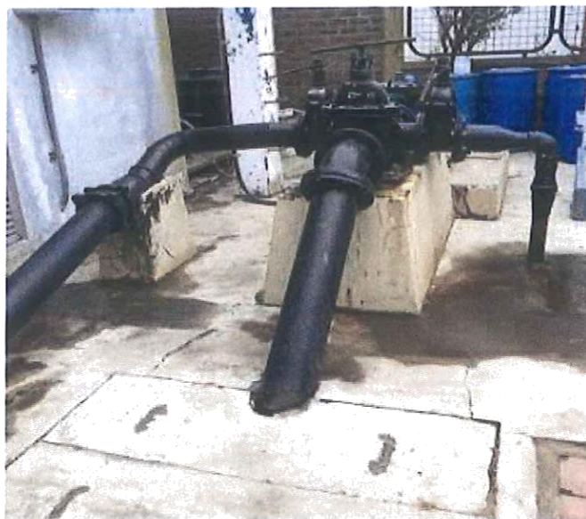
Figure 8.-Tubería de succión y descarga EB Norte
