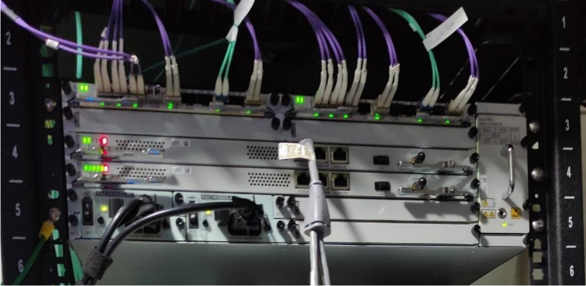
Ilustración 3: Switch L3 Huawei.
