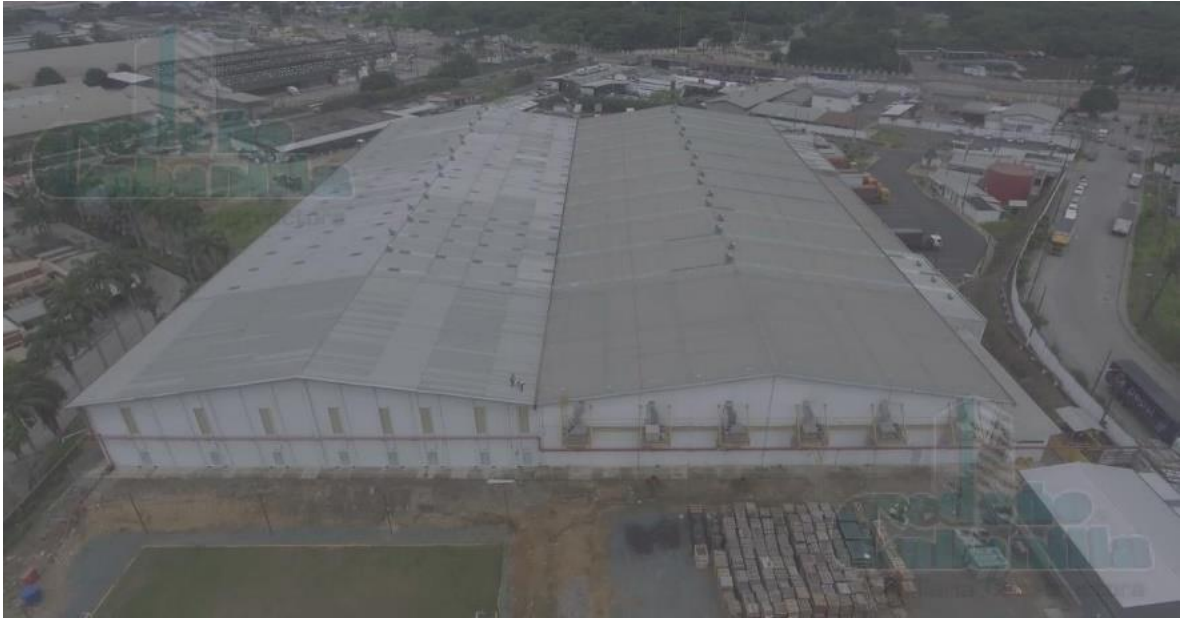
Figura 9. Bodegas de almacenaje ubicadas en la vía a Daule
