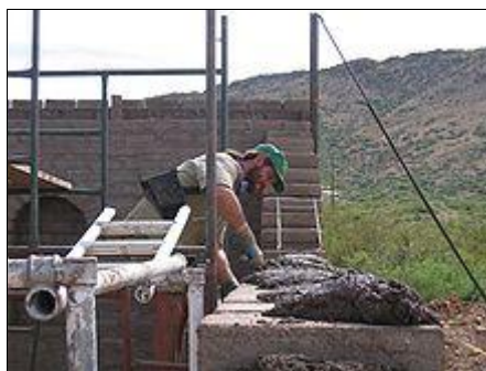
Figura 15. Servicio de albañilería
