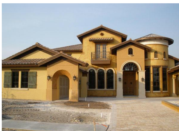
Figura 14. Servicio de pintura
