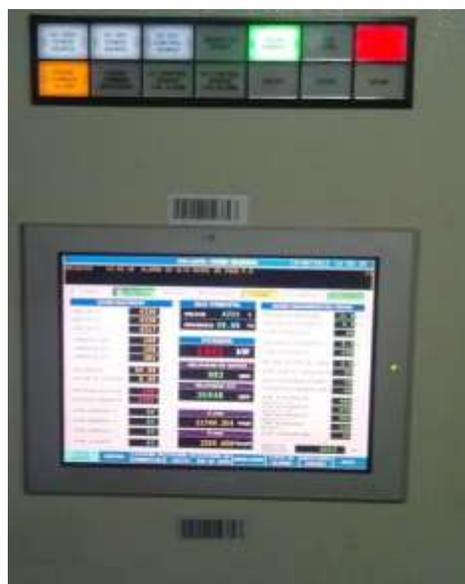
Figura 10. Código de barras instalado en un tablero de control
