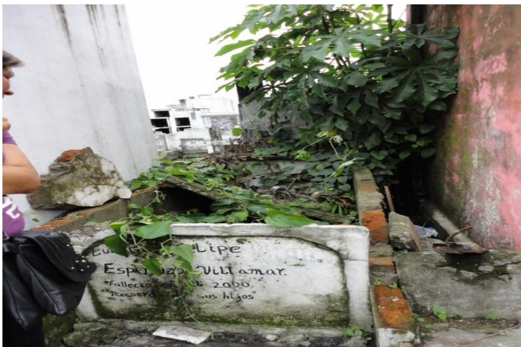
Figura 3 Imagende las bóvedas destruidas en el cementerio de Milagro
