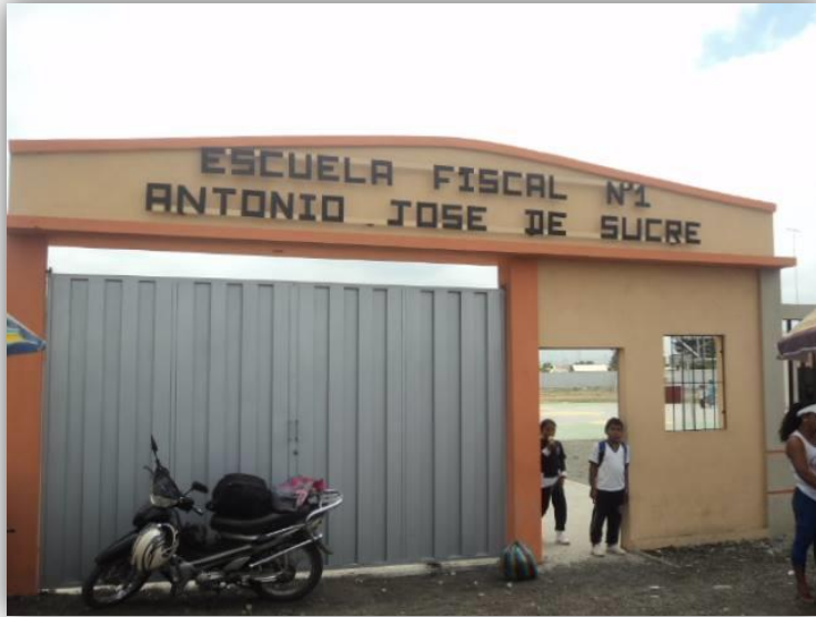
FACHADA DE LA ESCUELA ANTONIO JOSE DE SUCRE DEL CANTON MILAGRO.
