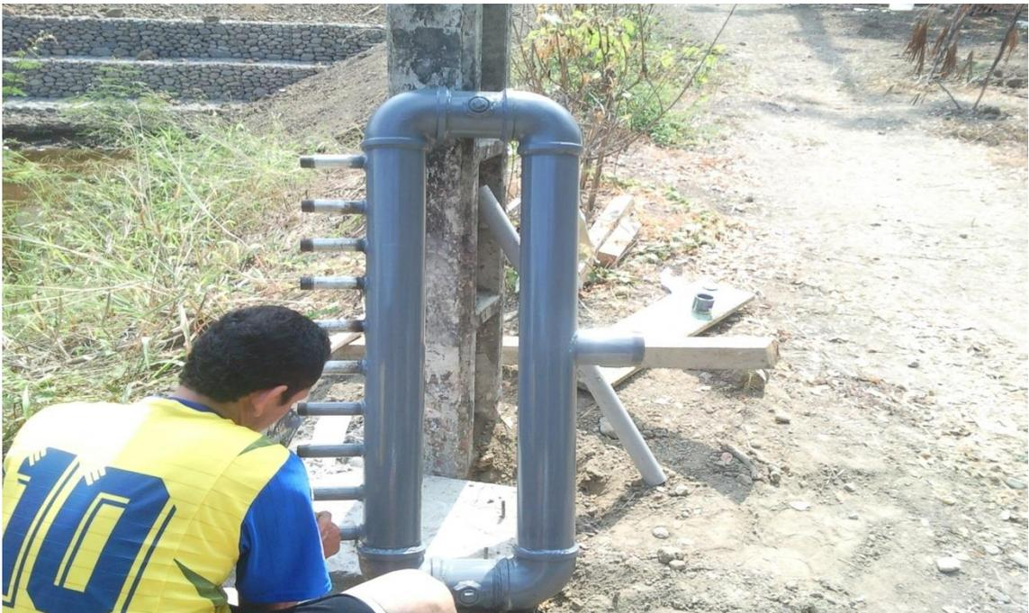
**Figura 30.** Acoplamiento de accesorios en el distribuidor (MANIFOLD).
