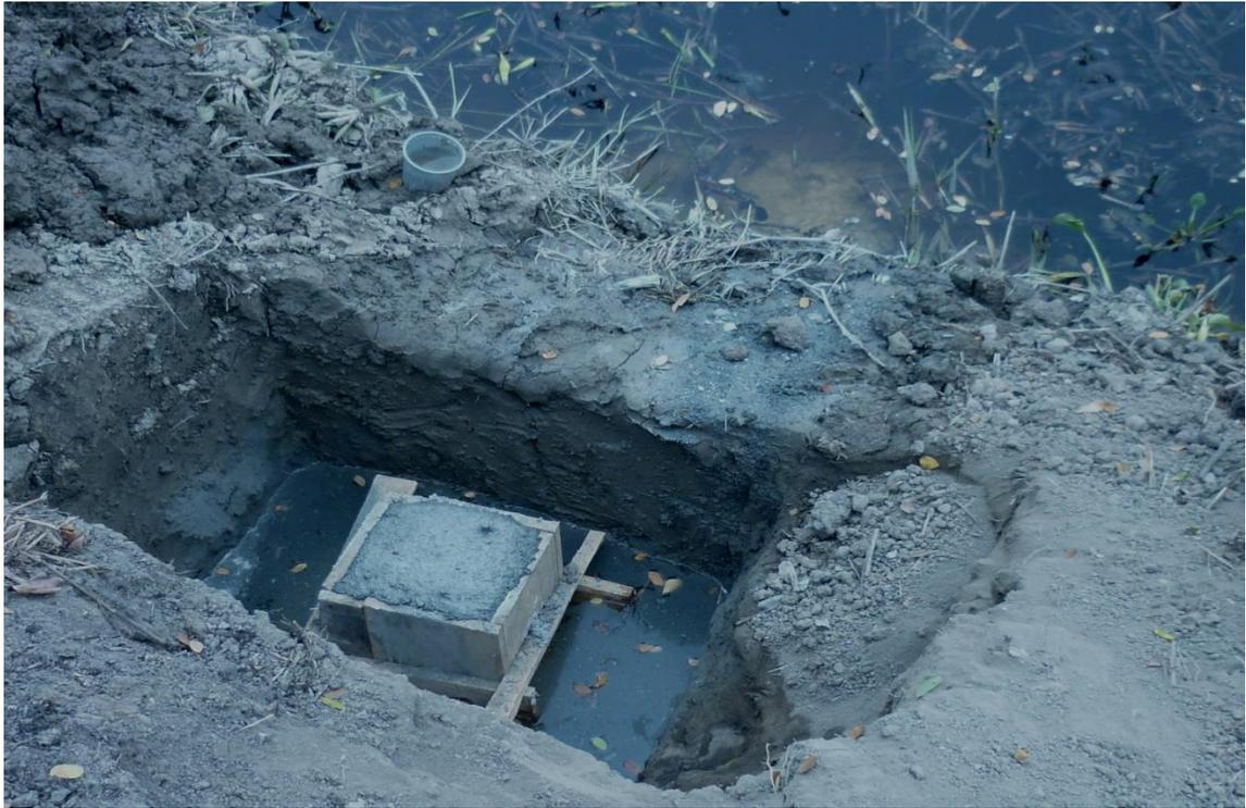
**Figura 25.** Construcción de la base del tensor.
