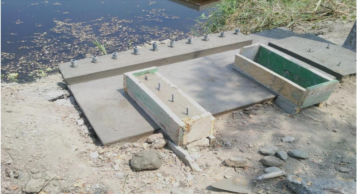
**Figura 27.** Construcción de la base del distribuidor (MANIFOLD).
