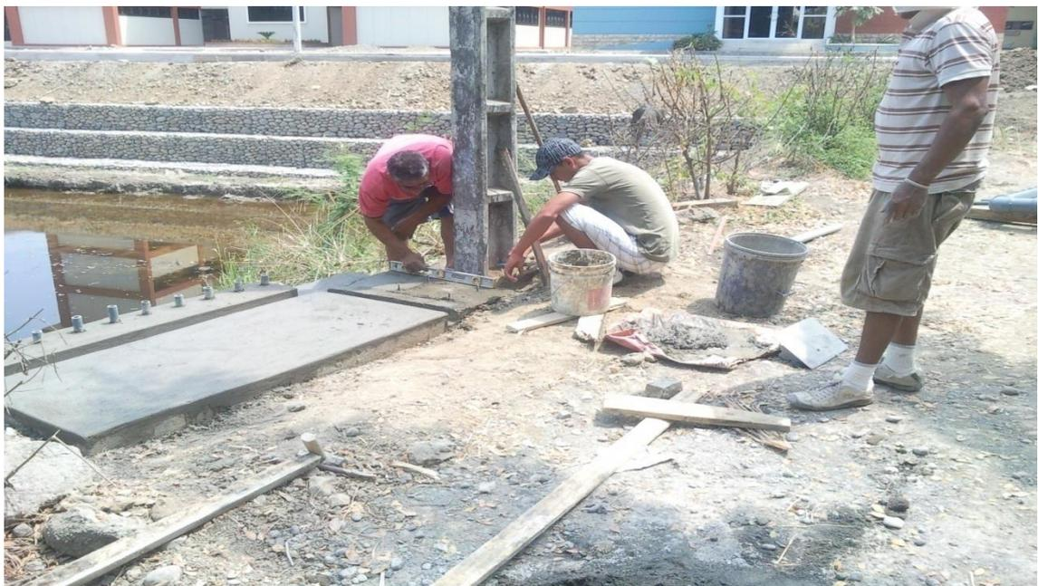
**Figura 26.** Construcción de las bases del motor y distribuidor (MANIFOLD).
