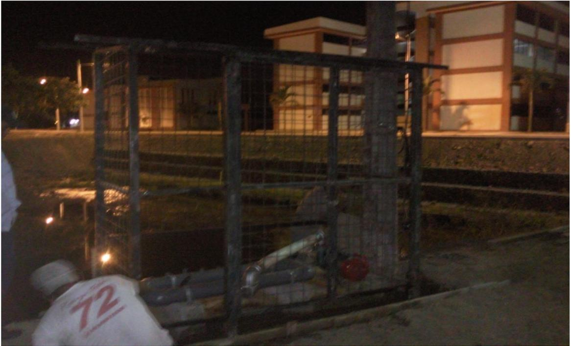
**Figura 33.** Construcción de estructura metálica de protección.
