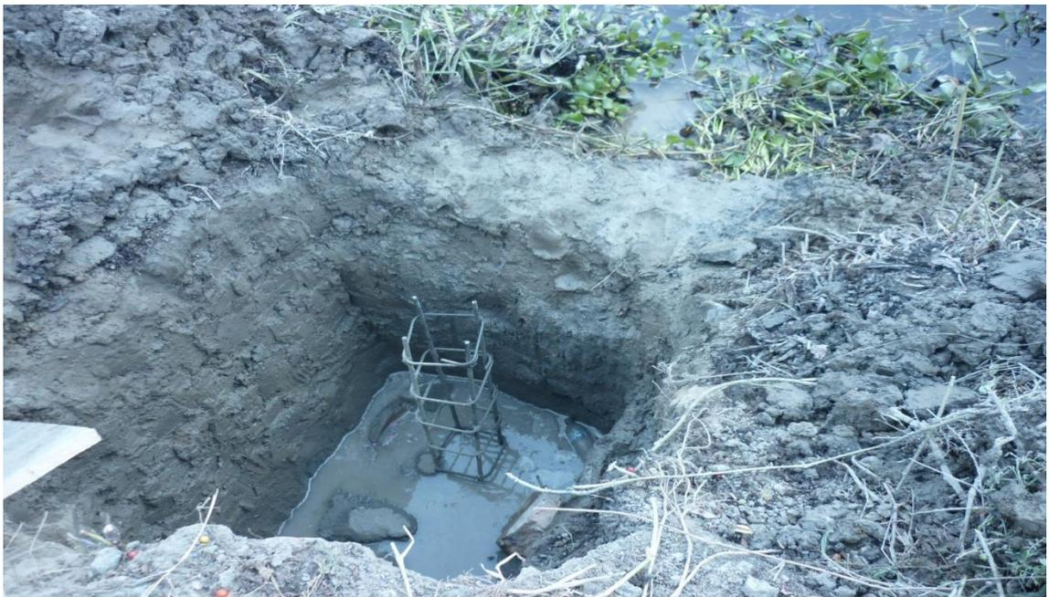
**Figura 24.** Construcción de la base del tensor.
