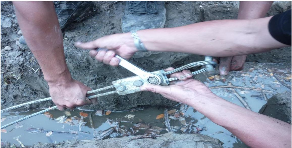
**Figura 28.** Colocación y ajuste de los tensores en las bases ya construidas.
