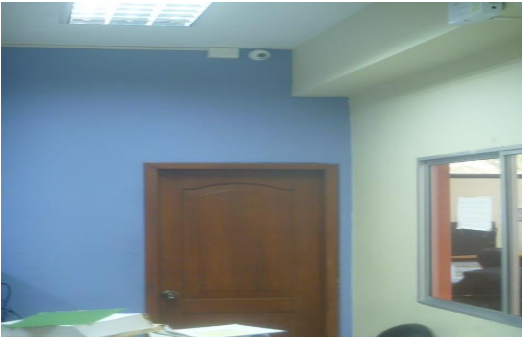
FOTO 6. SALON ADMINISTRATIVO-PLANTA BAJA
