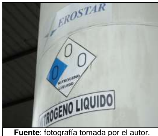
Figura 2. Rombo de seguridad en tanques de almacenamiento de O y N de Aerostar.
