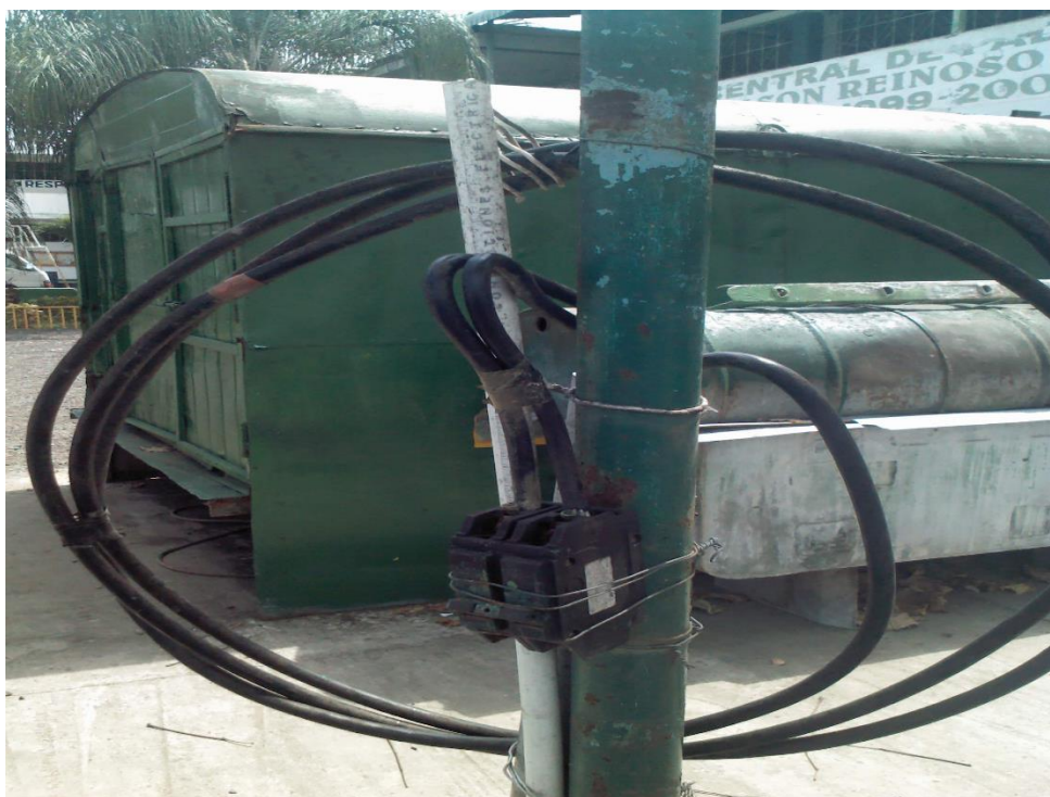
Instalación del compresor
