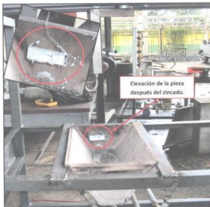
Foto 16. Retiro de las piezas expuestas al baño de zinc.
