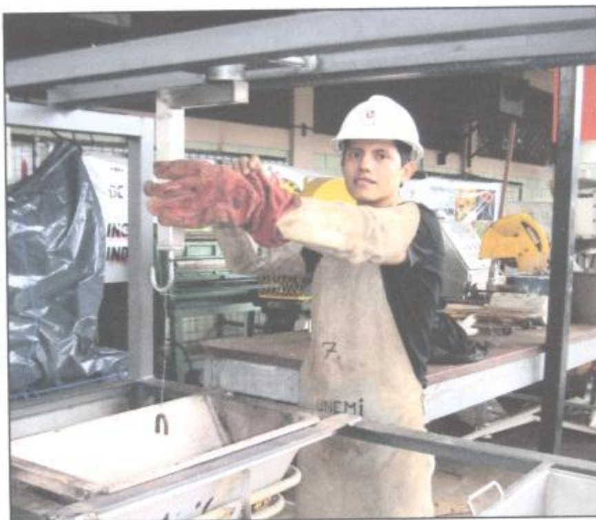
Foto 13. Transportación de la varilla corrugada de 1/8" en el baño de zinc.
