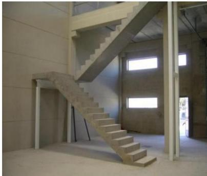
**Figura 2.** Escaleras de hormigón
