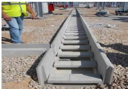
**Figura 3.** Canal de cables de hormigón
