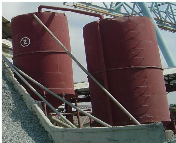
**Figura 33.** Almacenamiento en silos del cemento
