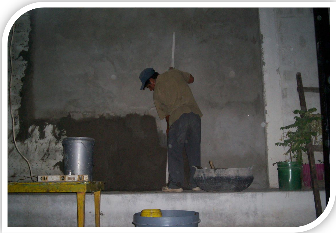
Enluciendo el fondo de la pared de la grada
