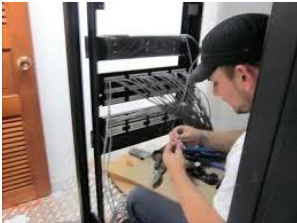
**Figura 26:** Instalación de sistema de cableado.
