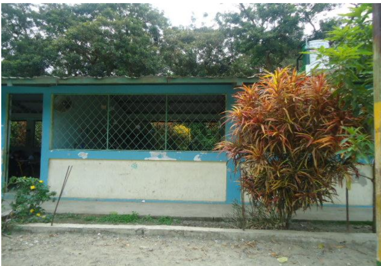
Infraestructura de la Escuela Fiscal Mixta N°10 “Francisco de Orellana”
