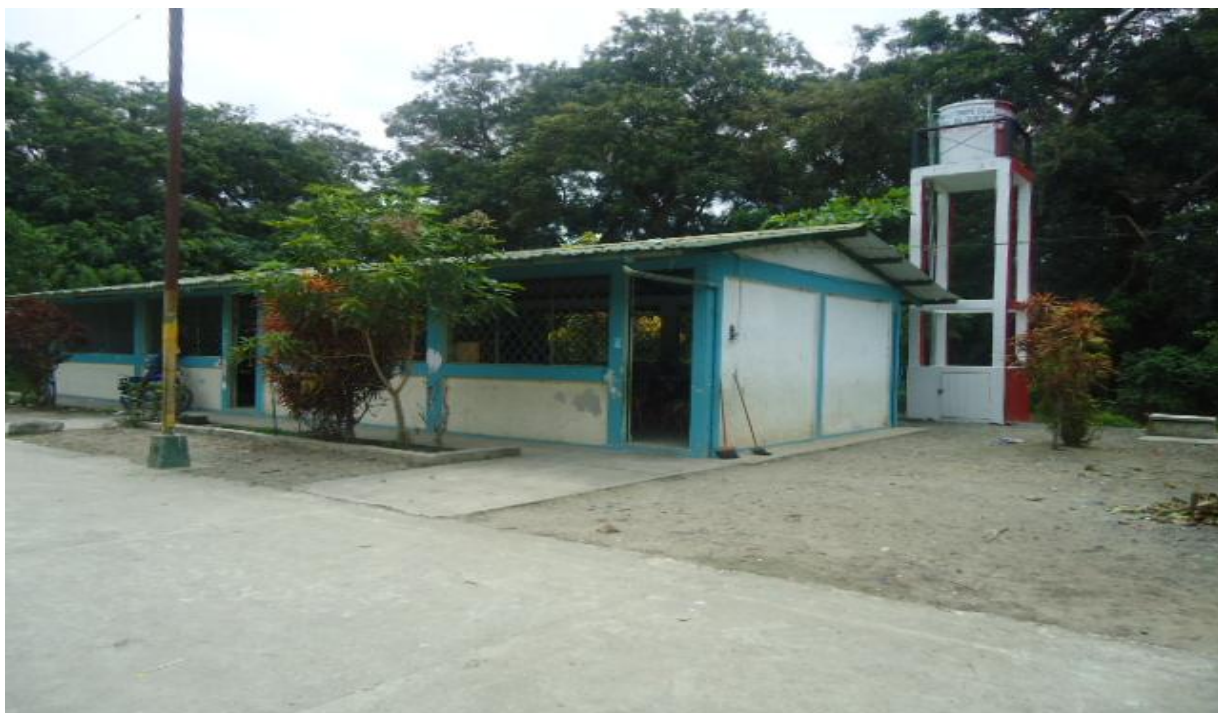
Infraestructura de la Escuela Fiscal Mixta N°10 “Francisco de Orellana”
