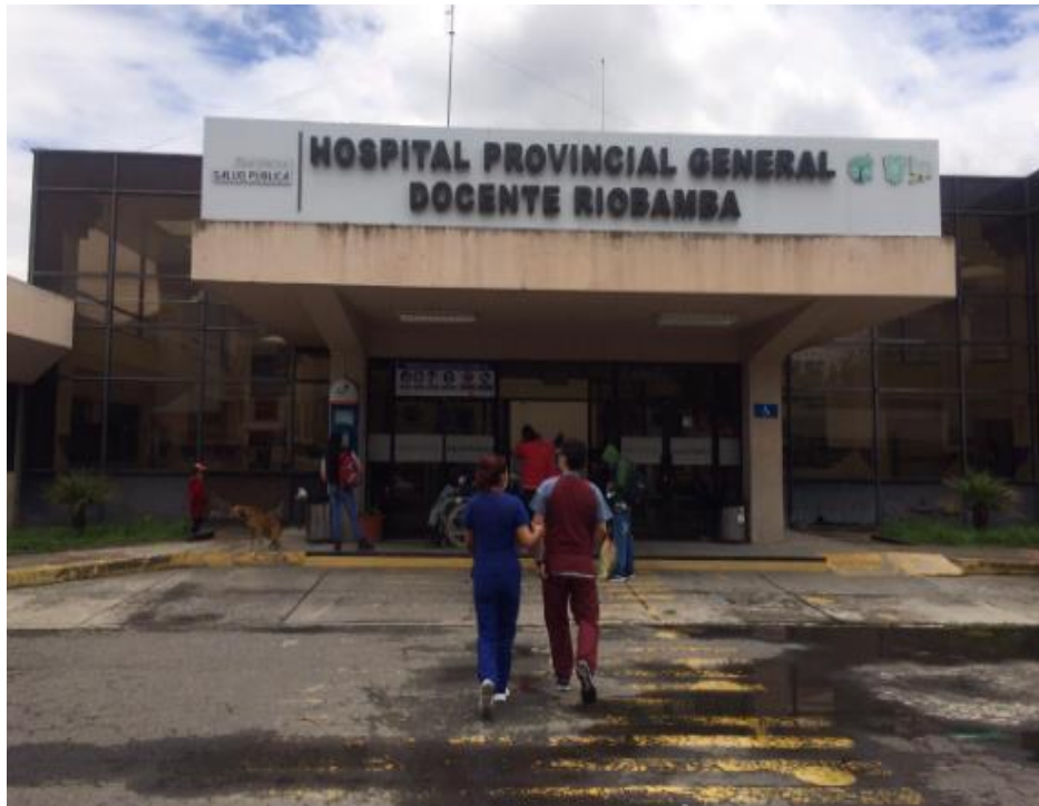
Figura 24. Hospital General Docente de Riobamba
