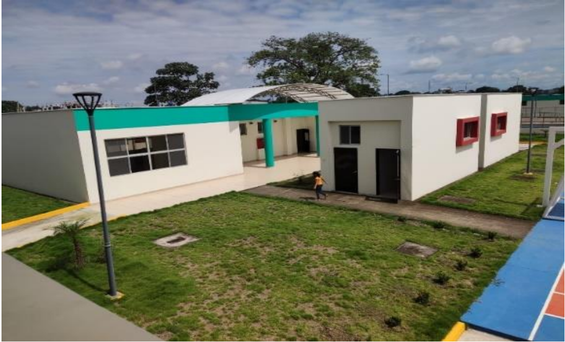
Anexo 1 Infraestructura del Colegio Otto Arosemena Gómez.
