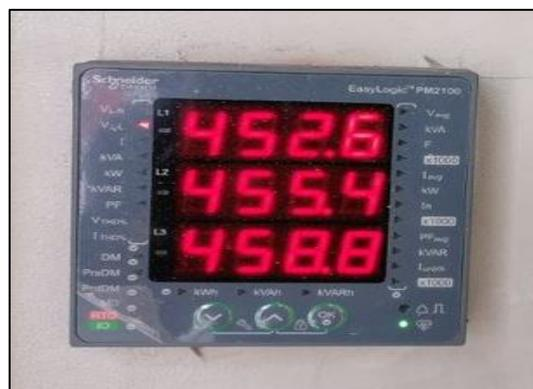
*Figura 10.* Medidor eléctrico digital PM2100. Fuente: Elaboración propia.
