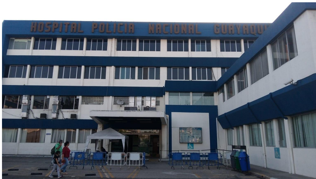
Anexo I: Imagen de entrada principal del edificio hospitalario del HPNG2
