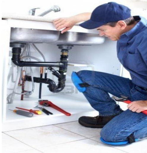
Guía Completa sobre Plomería: Materiales Modernos
