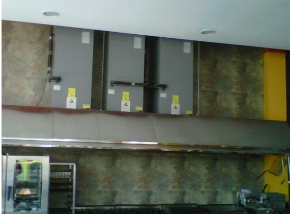
Figura Nº 20: Campana extractora de olores
