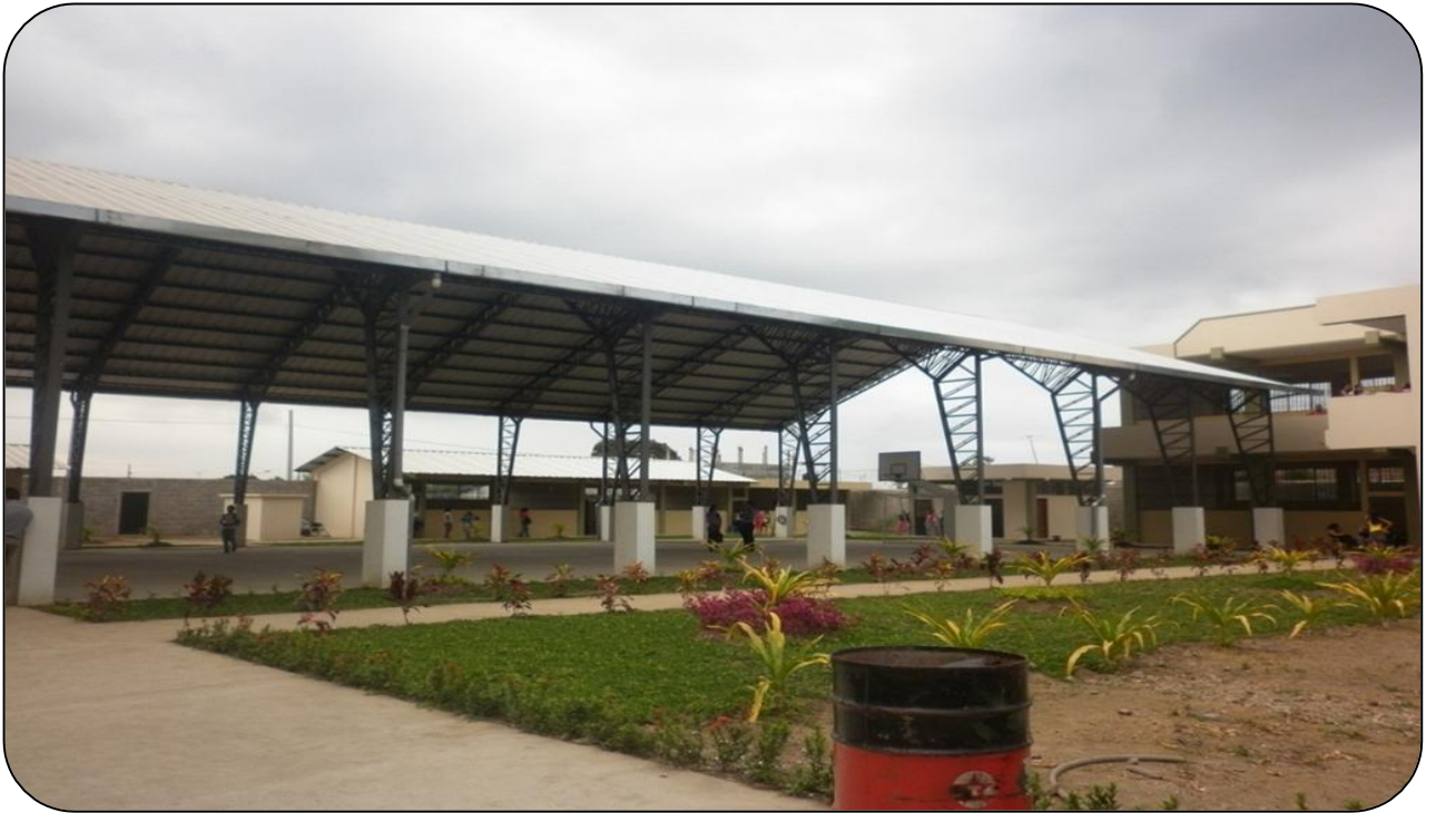
Cancha polifuncional (fútbol y básquet), con cubierta de techo.
