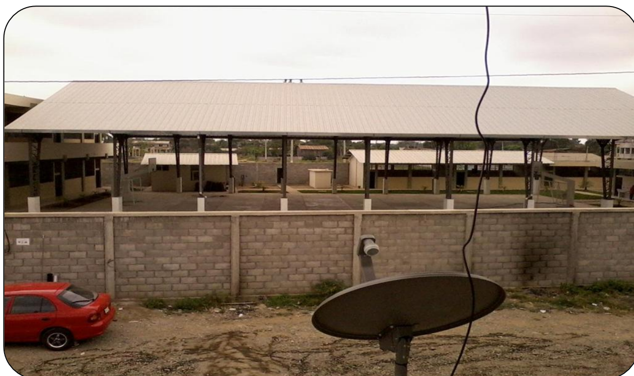
Nuevas instalaciones donde actualmente funciona la Escuela Francisco Polit Ortiz.
