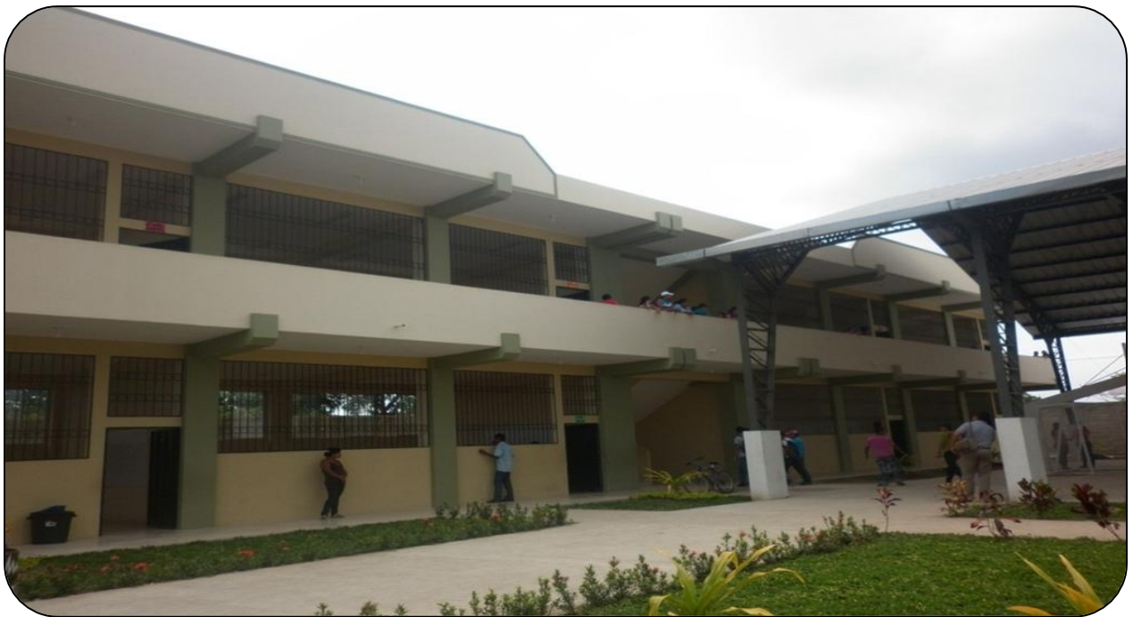
Infraestructura de la Escuela
