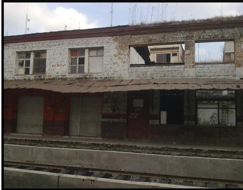
Grafico 15. Estructura donde se instalara el I-TUR
