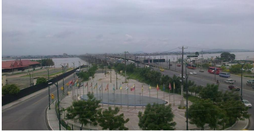
Figura 12, Vista panorámica del puente de la unidad Nacional junto a la Estación del Ferrocarril
