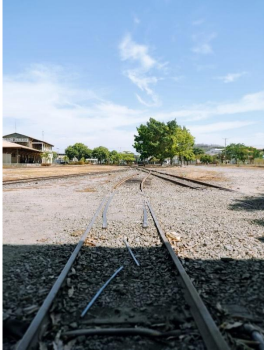
Figura 10 , Actual estación de tren tomada durante la investigación de Campo
