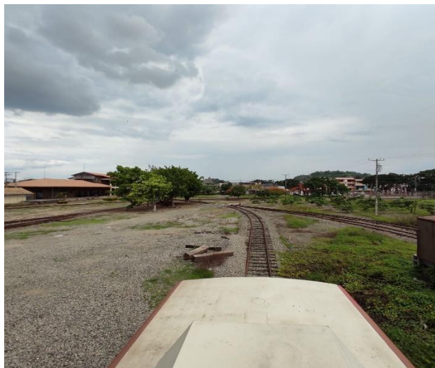
Figura 9, Actual estación de tren tomada durante la investigación de Campo
