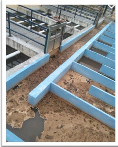
*Anexos 7: Floculación y sedimentación con sulfato de aluminio*
