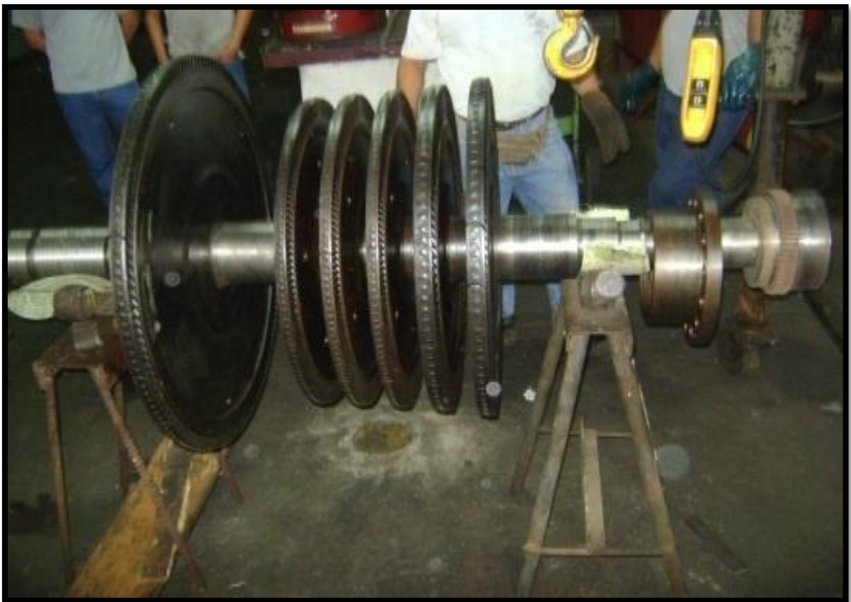
Figura 8. Rotor previo al proceso de armado de disco
