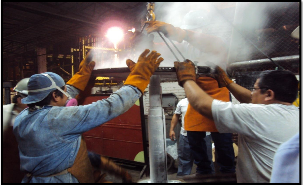
Disco de turbina, al momento de colocarlo en el eje
