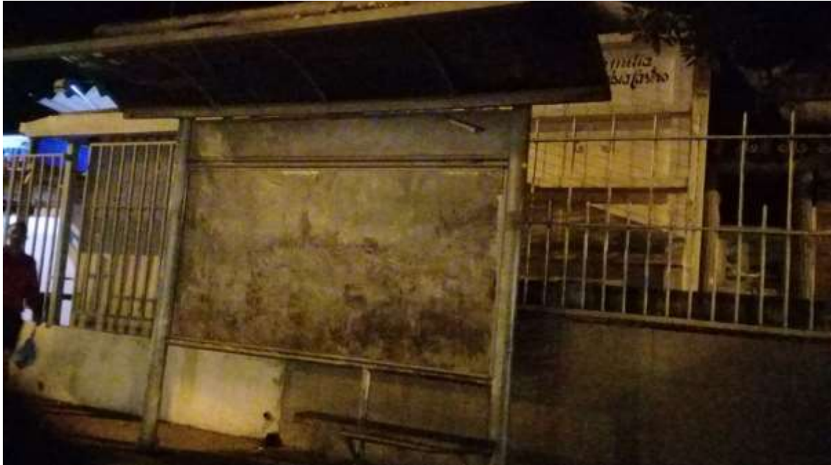
Imagen 2. Parada de refugio peatonal
