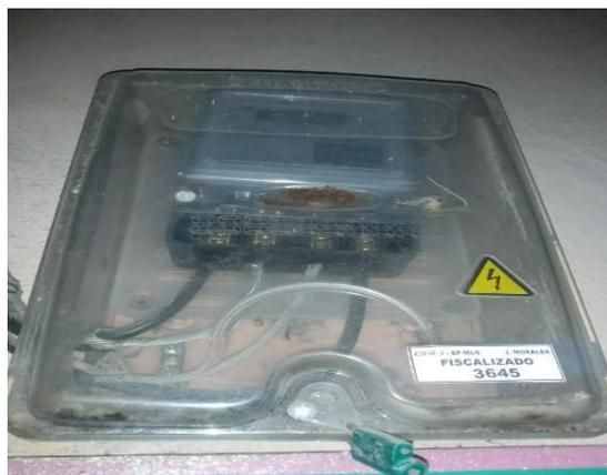
Ilustración 8: Medidor de energía eléctrica.
