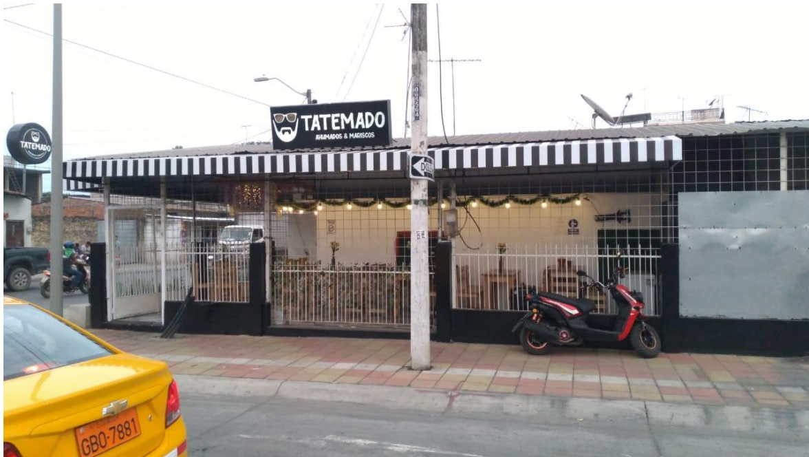
Figura 7. Detalle de la instalación desde parte externa del restaurante Tatemado – Ahumados y Mariscos (Tatemado, 2021)
