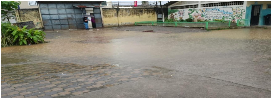
FALTA DE SEGURIDAD EN EL INGRESO A LA INSTITUCIÓN EDUCATIVA
