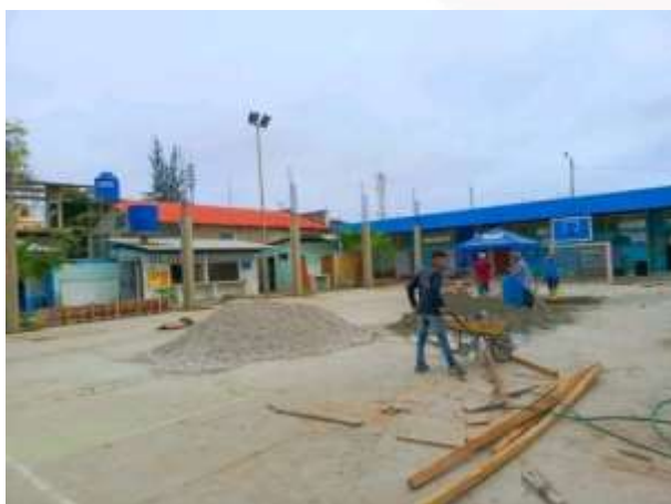
Apéndice 1 Trabajando en construcción de un pabellón
