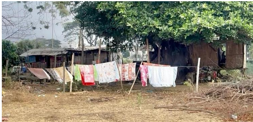
Fotografía 5 Viviendas con material no duradero en el Malecón del Salto
