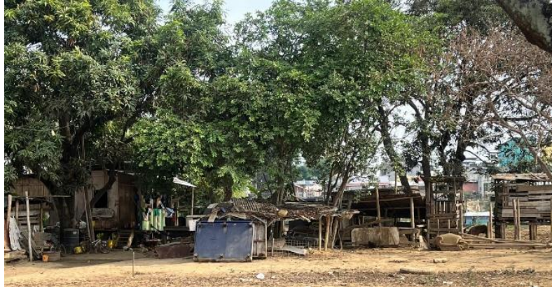
Fotografía 4 Viviendas con material no duradero en el Malecón del Salto
