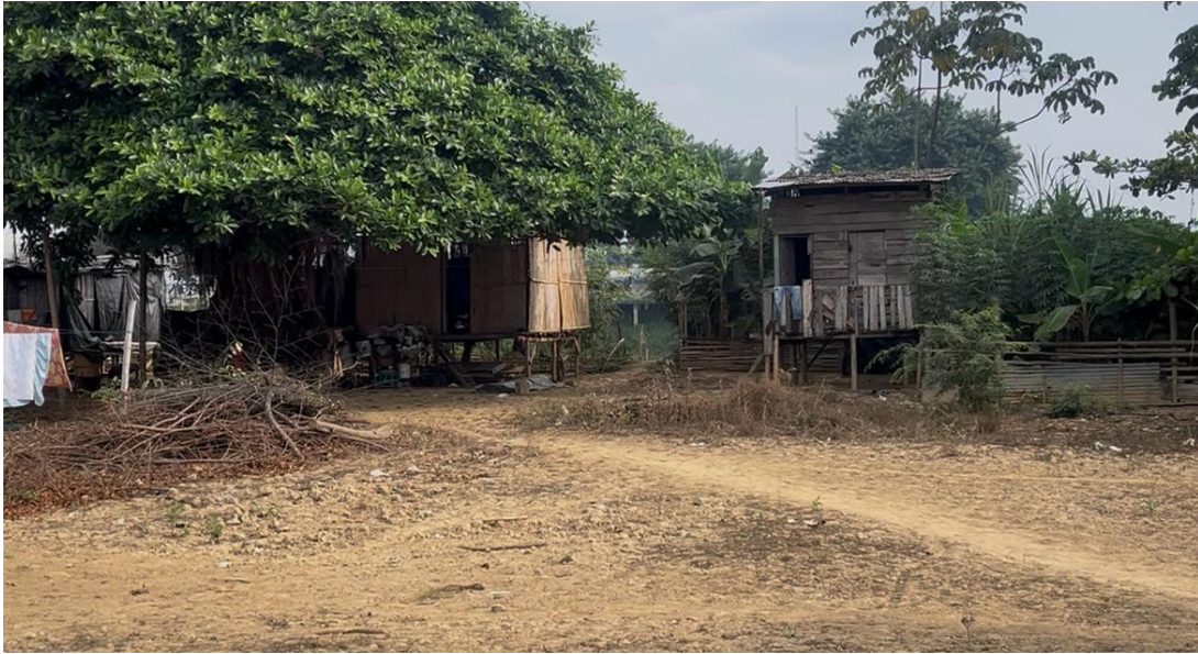
Fotografía 10 Viviendas ubicadas de manera informal en el tramo malecón del Salto
